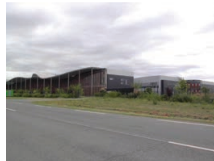
Centre de recherche Danone Vitapôle, implanté depuis plusieurs années à l'Ouest de la RD 128
