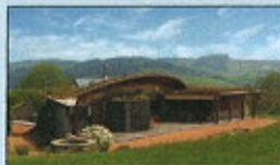
MAISON BIOCLIMATIQUE DANS LE SUD DE LA FRANCE (PROVENCE)
